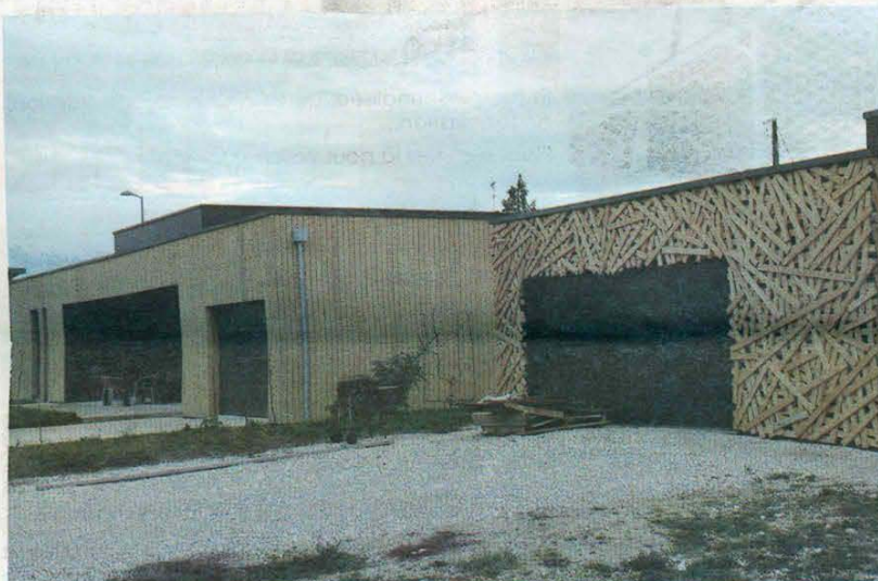
Deux maisons passives ont été construites dans l'éco-quartier de Pont-Sainte-Marie.
